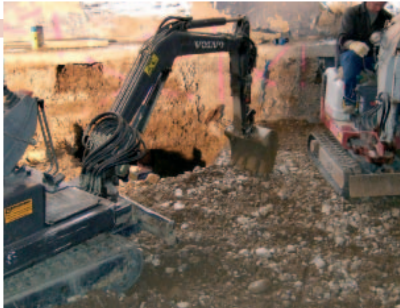
Um die Räume im Keller höher zu machen, werden die Fundamente des gesamten Gebäudes nachträglich tiefer gelegt – eine bautechnische Meisterleistung!
