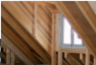
Renoviertes Dachgestühl nach dem Brand
